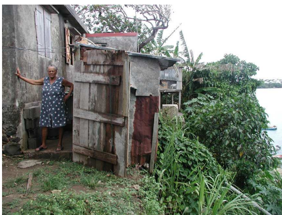
Construction en bordure de falaise
