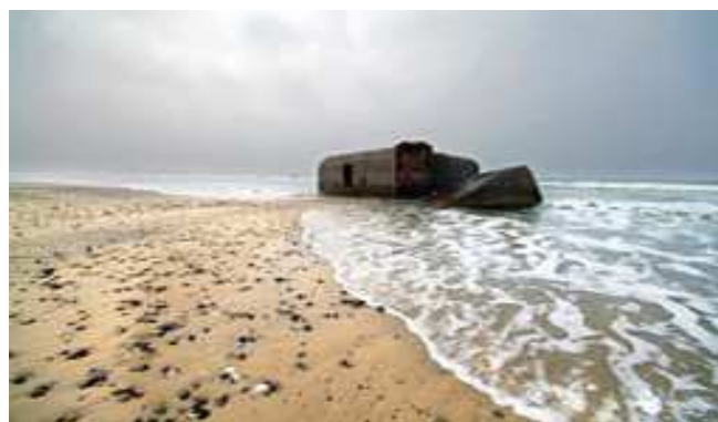
Les bunkers : marqueurs historiques de l'évolution du trait de côte
