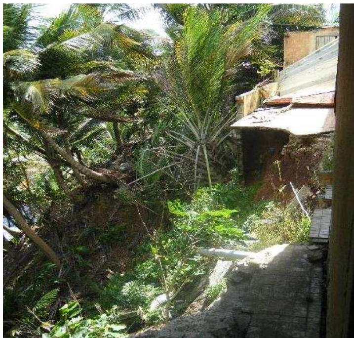
Point-à-Bacchus : construction en zone de glissement © CANBT
