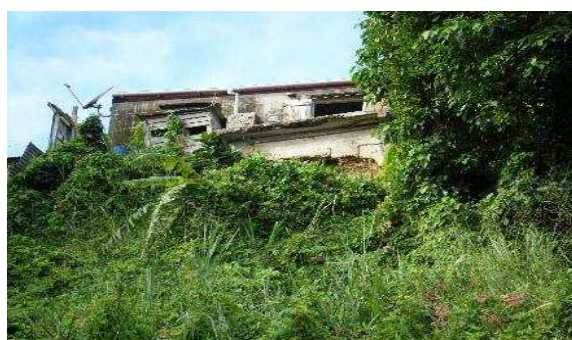
Bovis : construction à flanc de falaise © CANBT
