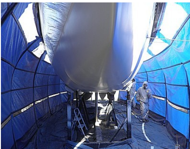
Figure 15 : Cocon de protection pour intervention sur coque de bateau (Source: equipementnautique.com , dans Cetmef, 2011).
