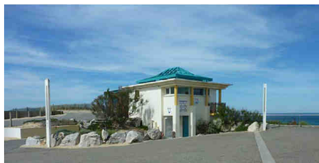
Poste de secours MNS de Labenne-Océan © GIP Littoral Aquitain
