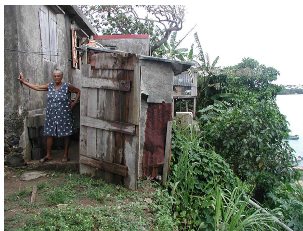
Construction en bordure de falaise © CANBT
