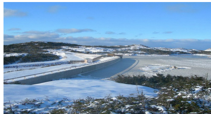
Barrage du Goéland – Source :Dossier des Risques Majeurs 2013
