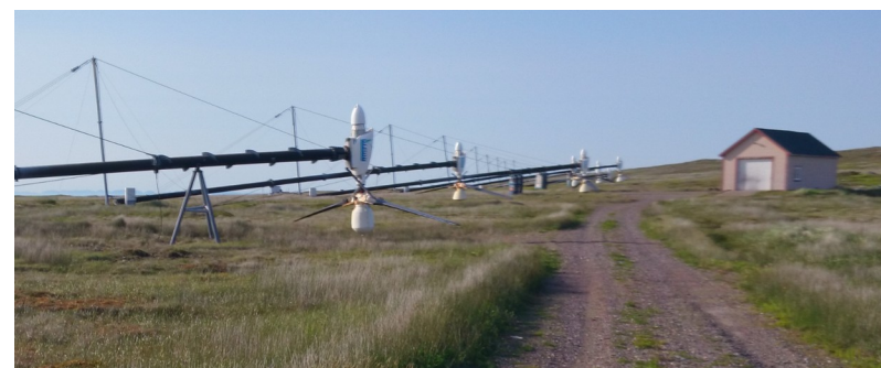
Éoliennes terrestres démontées - Source : CEREMA, 2016
