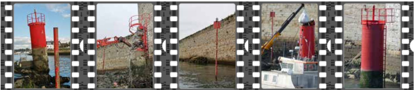
Remplacement d'une tourelle par les services de la DIRM NAMO
